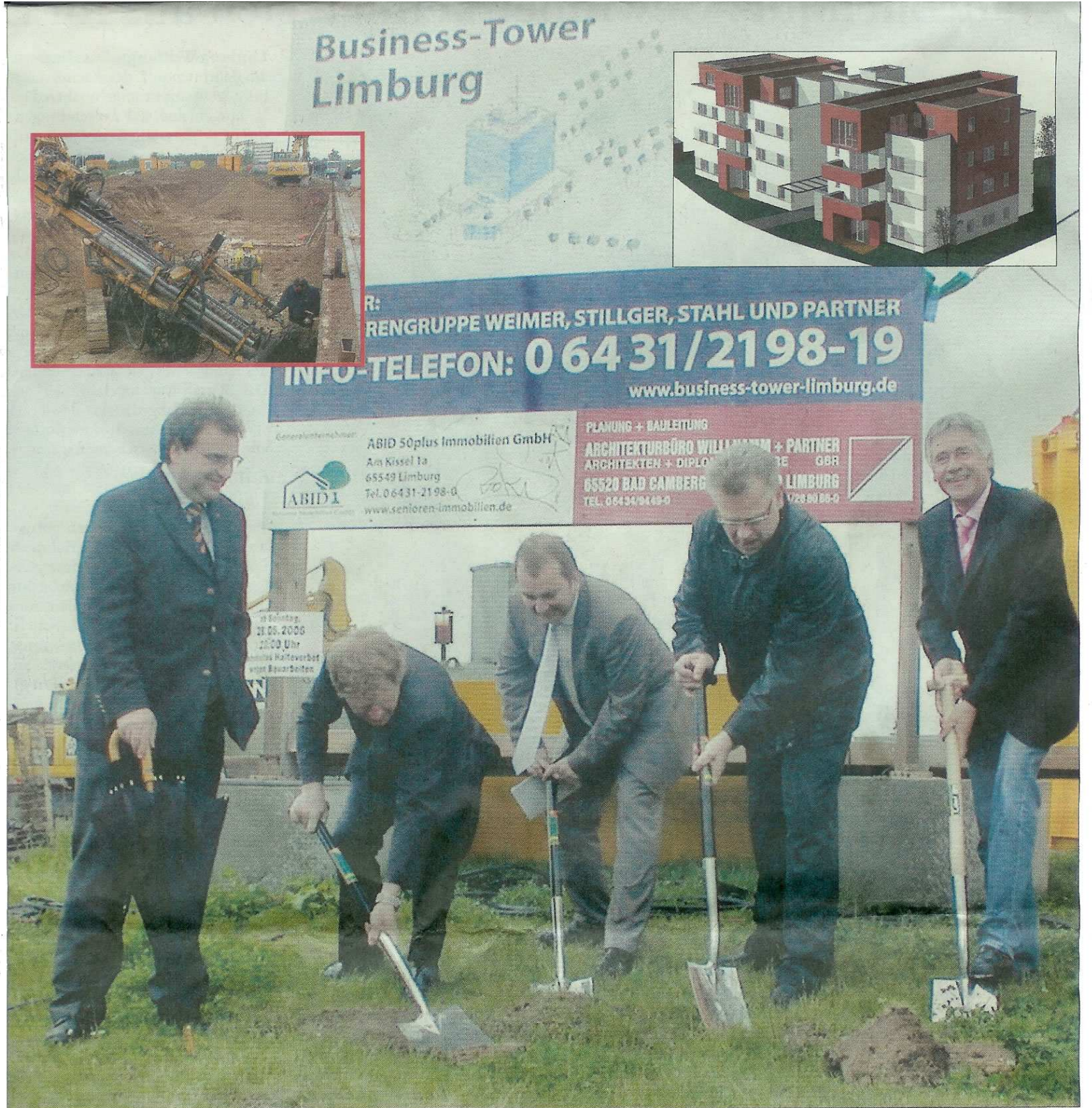
Feiertag im ICE-Gebiet. Während die Maschinen sich hinter dem großen Hinweisschild in die Erde gruben (kleines Foto oben links), setzten Armin Stahl (2.v.l.) Markus Stillger, Bürgermeister Richard und Georg Weimer unter den Augen von Willi Hamm (links) zum ersten Spatenstich an. In der Innenstadt entsteht zudem ein neues Projekt mit 17 Wohnungen (kleines Foto oben rechts). Fotos: Laubach (2)/Kramm
