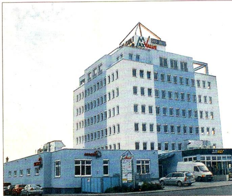
Das erste erfolgreiche Jahr haben der Max Value Tower und die dort angesiedelten Firma bereits hinter sich. Foto: in Concas
